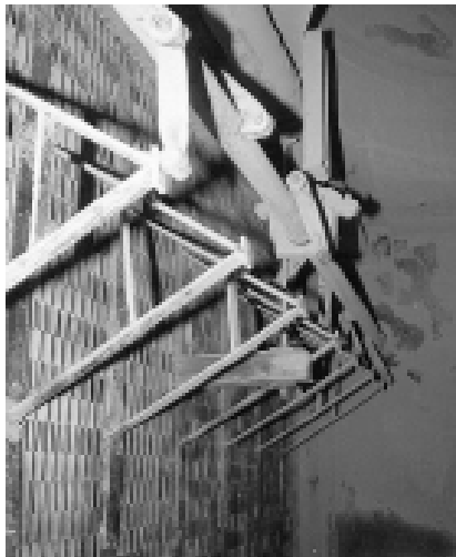
Abb.3 MULTIWIR-Staubabscheider mit Klopfvorrichtung
